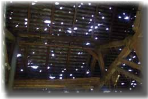
Durchsiebtes Garagendach nach dem Hagelunwetter
